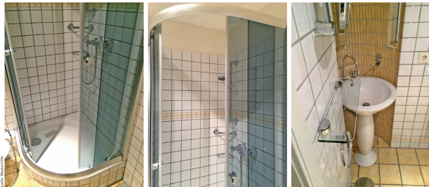
Vor dem Umbau: Die Bäder wirkten sehr dunkel, die Duschkabinen waren eng und wenig komfortabel.
