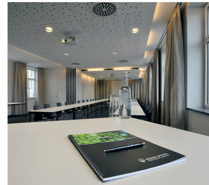
Im Konferenzraum befinden sich leistungsstarke Kanaleinbaugeräte in der Decke. Deutlich zu sehen sind die Drallauslässe für den Luftausblas.
