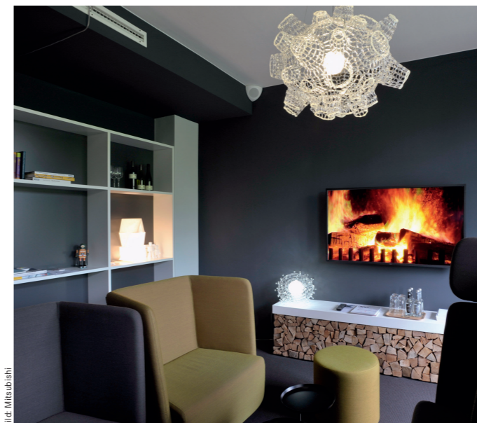
In der Fireside Lounge sorgt ein Kanalanschlussgerät mit Absaugung über einen bodentiefen Luftkanal für eine behagliche Luft- und Temperaturverteilung im Raum.
