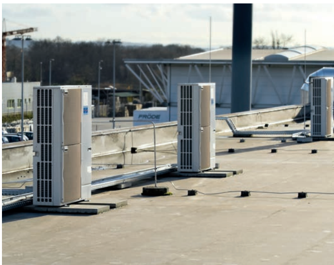
Der geringe Platzbedarf sowie das verhältnismäßig niedrige Gewicht der Außeneinheiten ermöglichen eine problemlose Dachaufstellung.
