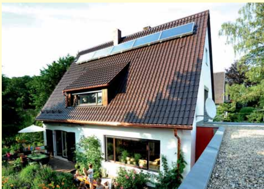
Einfamilienhaus mit Solar-Luftkollektormodulen. Die Reihenschaltung gewährleistet hydraulisch günstige Strömungsbedingungen.
