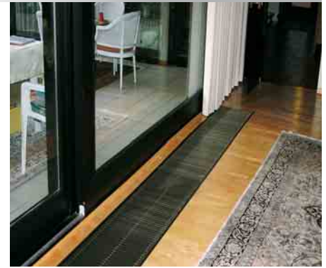
11 Unterflurschacht in einem Privatwohnhaus (Baujahr 1975) mit nachträglich angebautem Wintergarten
