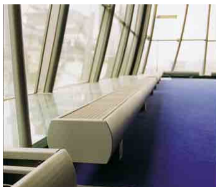
⑦ Haubenkonvektor im deutschen Expo-Pavillon Hannover
