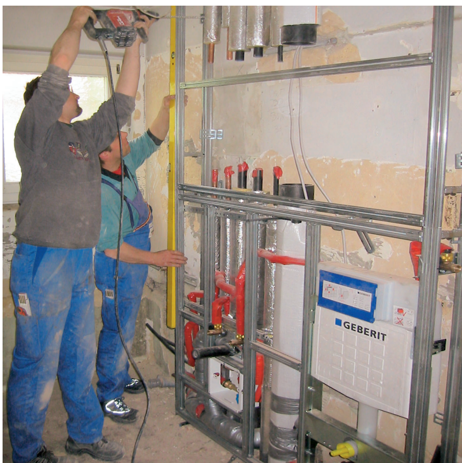
Das vorgefertigte Tragsystem wird am Baukörper befestigt.
