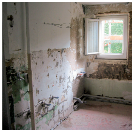
Das Bad im entkernten Zustand
