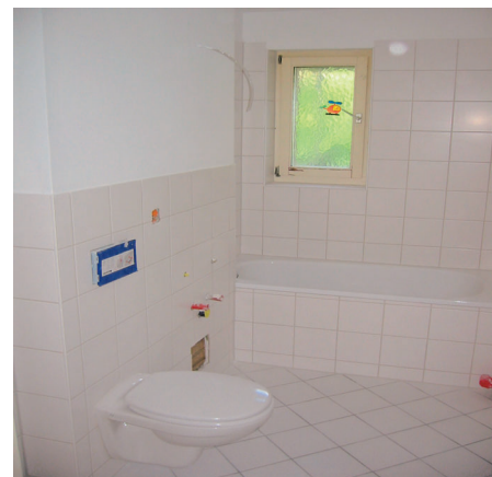
Fertig installiertes neues Bad
