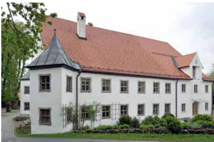
Der älteste Teil des Pflegeamts- und Gerichtsgebäudes im Alten Schloss Valley: Das denkmalgeschützte Gebäude ist heute Teil eines weltweit einzigartigen Orgelzentrums.
