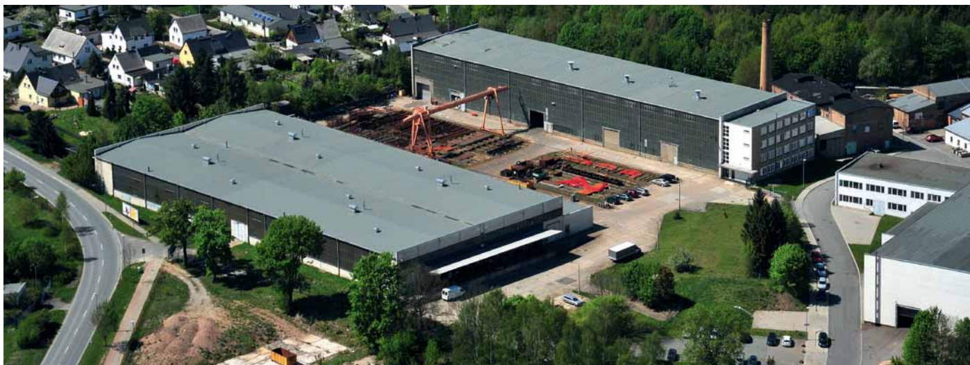
Ein modernes, dezentrales Warmluft- und Lüftungssystem sorgt für hohe Energieeinsparungen in einem sächsischen Maschinen- und Stahlbauunternehmen.
