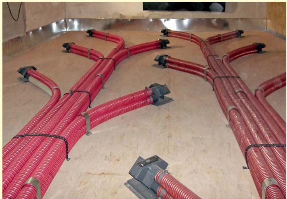
Der umfunktionierte Kellerraum: Auf dem Boden des Lagers wurden die Saugsonden verteilt, damit die Austragung der Pellets vollflächig erfolgen kann.
