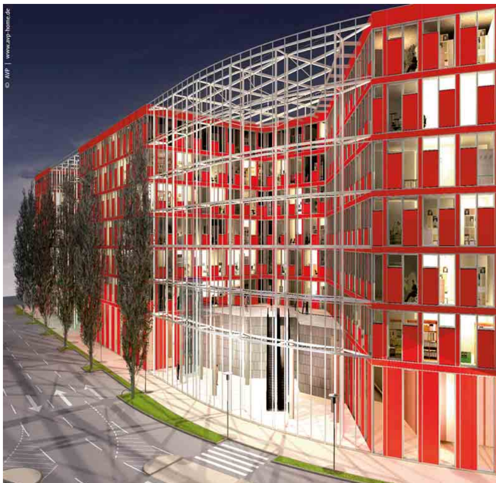
1 Das CAPRICORN-HAUS im Düsseldorfer Medienhafen ist eine gelungene Kombination aus anspruchsvoller Architektur und moderner Gebäudetechnik.
