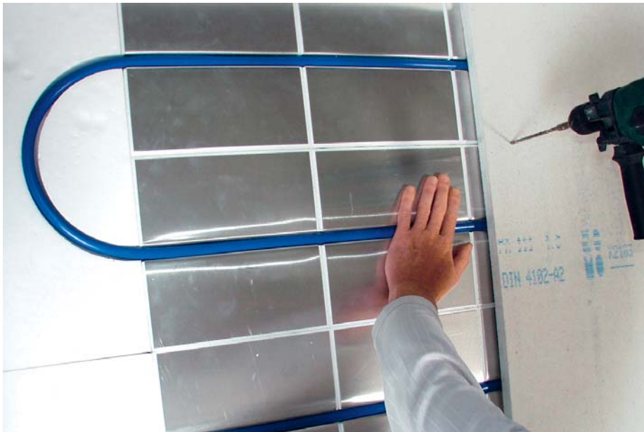
Die Trockenbauplatten werden angebracht. Darunter sind gut die Heizrohrleitungen sowie die Trägerplatte zu erkennen.
