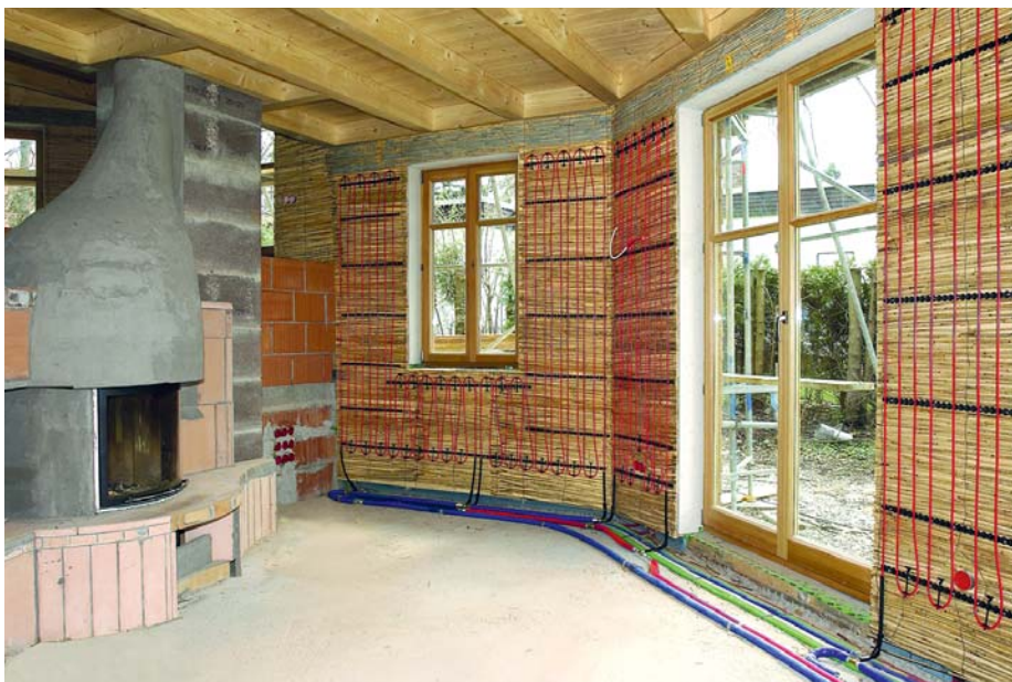
Eine Wandheizung stellt insbesondere dann eine gute Alternative dar, wenn die Deckenhöhe oder die Statik der Decken den Einbau einer Fußbodenheizung nicht erlauben.
