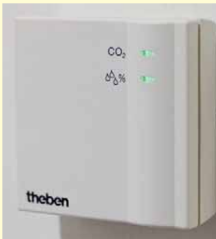
Raumluftqualitätssensor, wie er sich in jedem Klassenzimmer befindet und den Zeitpunkt der Fensterlüftung anzeigt
