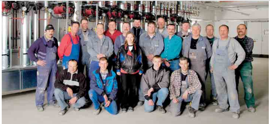
③ Das Team der Lodewick GmbH, Herzberg, das für die Ausführungsmontage der SHK-Gewerke im Lehrter Bahnhof („Berlin Hauptbahnhof“) verantwortlich ist. Im Hintergrund eine der Heizzentralen, in der alle Pumpen mit LON-fähigen Doppelpumpen der Baureihe Magna-D ausgerüstet sind.
