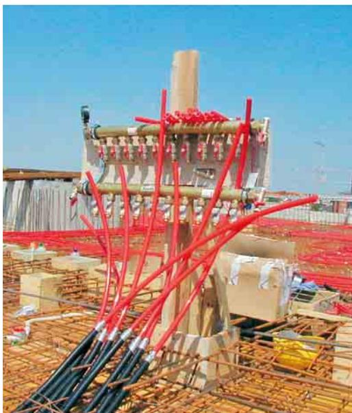
4 Druckprüfung der Betonkerntemperierungs-Module
