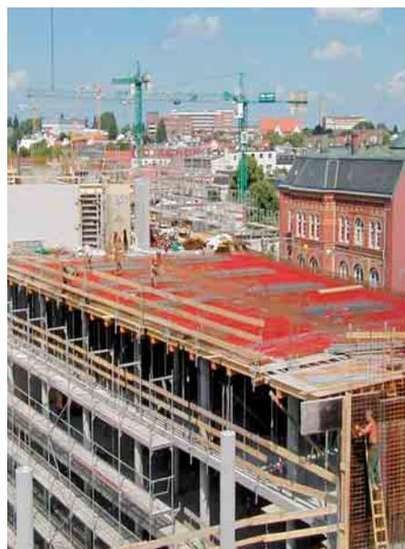
2 Auf etwa 4.500 m<sup>2</sup> wurden die REHAU Betonkerntemperierungs-Module verlegt.
