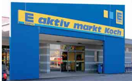
1 Der Edeka Aktiv-Markt in Schömburg ist wegweisend für einen effizienten Energieverbund zwischen Kälteerzeugung, Heizsystem und Geothermie.
