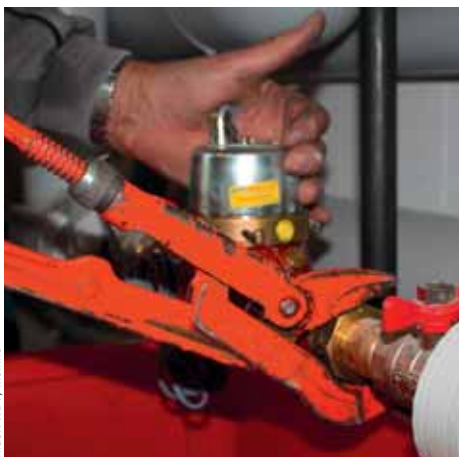
Einbau eines mechanischen Volumensmessteils in die waagerechte Leitung
