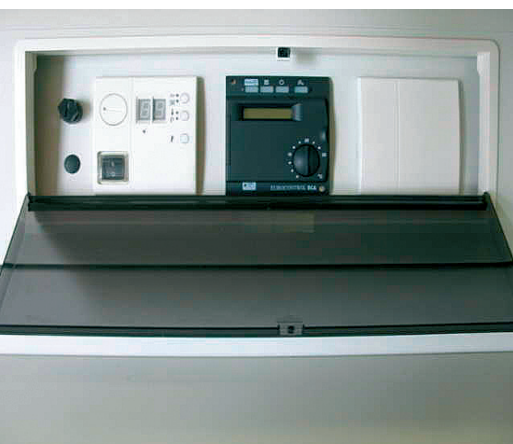
6 Der serienmäßig im SGB 2 eingebaute BCA-Kaskadenregler erlaubt eine Erweiterung der Anlage auf bis zu sechs Heizkessel und bis zu 40 Heizkreise. Er kommuniziert mit beliebigen Reglern der Euro-control-Serie über ein Bussystem.
