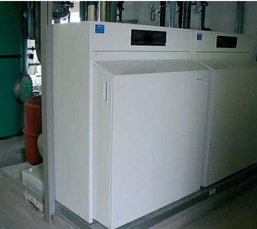
5 Die Unit-Bauweise der EuroCondens SGB 2-Baureihe von Brötje spart Platz und verkürzt die Einbauzeiten erheblich.
