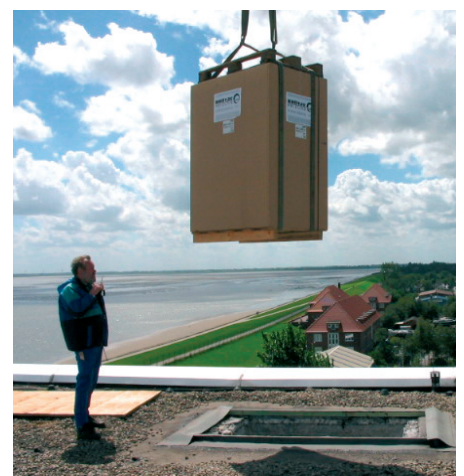
④ Da der Kran ohnehin für die Demontage der Altanlage vor Ort war, konnte der Heizkessel über eine Dachluke in den Aufstellraum eingebracht werden. Er passt allerdings auch durch eine Normtür.
