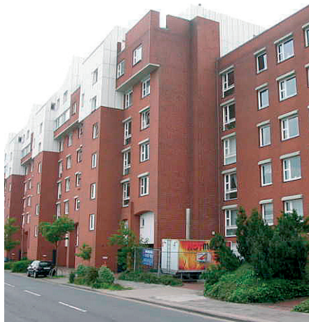
① Die Wohnanlage des Bauvereins Rüstringen e. G. mit 78 Wohneinheiten
