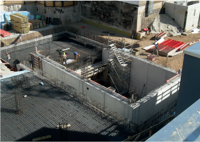
5 – Rohbau Kaltwasserspeicher
