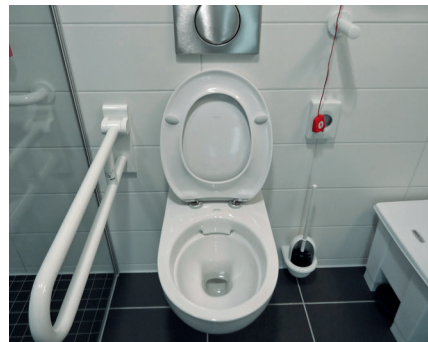
Die Rimfree-WCs sind ohne Spülrand gestaltet und weisen damit deutliche Vorteile in der Hygiene, Reinigung und Pflege auf.
