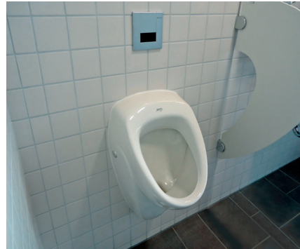
Auf den Herrentoiletten wurden Renova Nr. 1 Urinale installiert, die speziell für den Einsatz in öffentlichen Sanitärräumen konzipiert sind.
