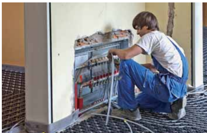
Die hohe Flexibilität des Heizrohrs vereinfacht sowohl die Verlegung als auch den Anschluss an die Heizkreisverteiler.
