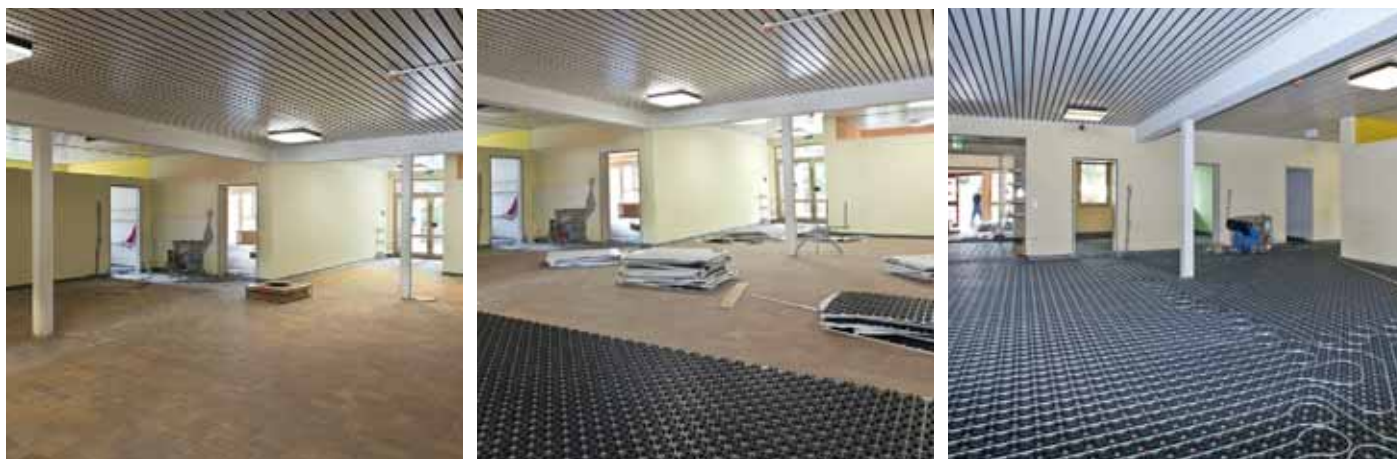
Von links nach rechts: Urzustand und vollständig mit xnet C15 ausgelegte Aula. Die Noppenelemente wurden einfach direkt auf den vorhandenen, gefliesten Boden aufgeklebt.
