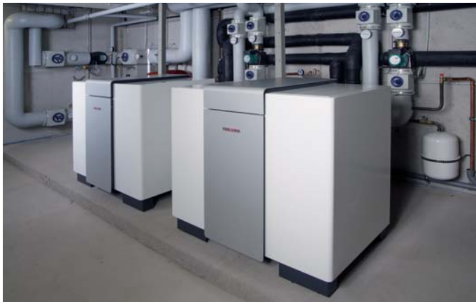
Standard-Wärmepumpen von Stiebel Eltron als Kaskade
