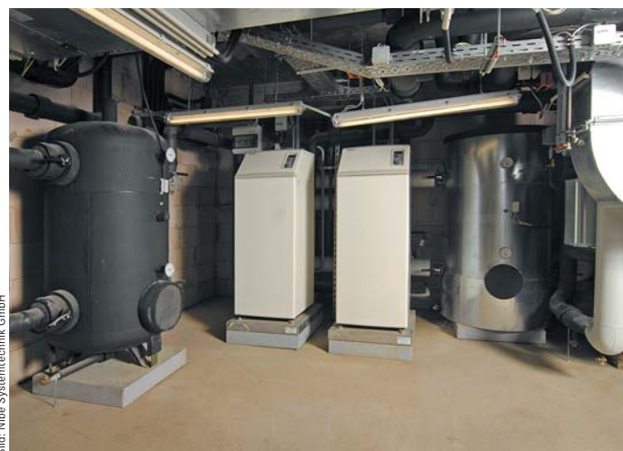
Wärmepumpen als Kaskade
