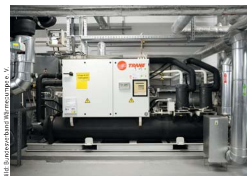
Großwärmepumpe mit Schaltschrank in der Technikzentrale des Ordnungsamts Frankfurt/Main
