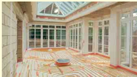
① Flächenheizung und -kühlung: Insgesamt wurden in der Villa 3.500 m cuprotherm verlegt.
