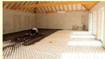
② Sonderlösung für die Garage: Kombination einer Schlüter-Noppenplatte mit dem cuprotherm-System
