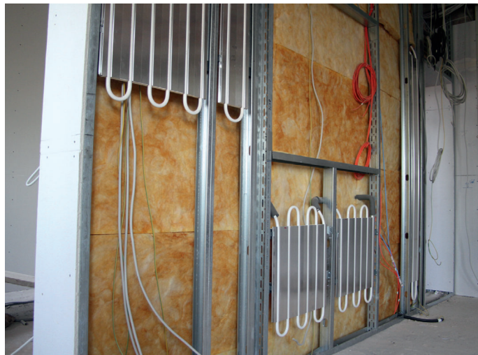
cupronova-Wandheizung in Ständerwand-Montage
