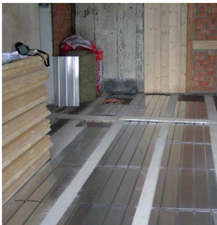
Passend für die Verlegung zwischen Holzbalken mit einer lichten Weite zwischen 50 bis 60 cm: Hier kann das System Siccus SW ohne jegliche Hilfskonstruktion verlegt werden.
