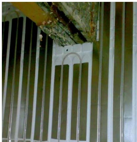
Je nach Ausführung und genutzter Fläche erreicht die Flächenheizung Siccus im Amtshaus monovalent eingesetzt eine Leistung von 70 bis 120 W/m 2 .
