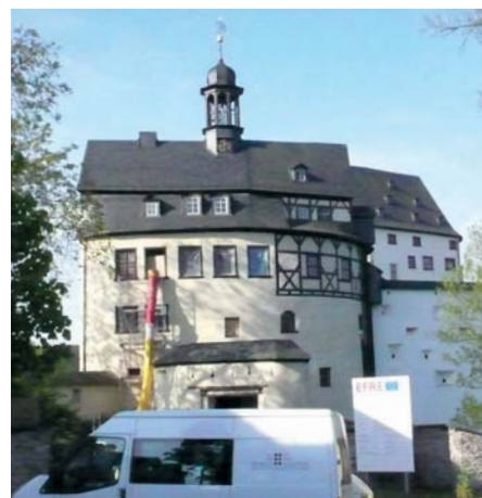
Im Rahmen der Renovierung der gesamten Burganlage wurde das ehemalige Amtshaus auf den neuesten haustechnischen Stand gebracht.
