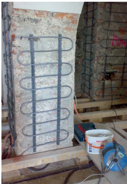
Im Amtshaus wurden für die Temperierung mit Siccus sogar vorhandene Säulen mit dem Klemmschienensystem bestückt.
