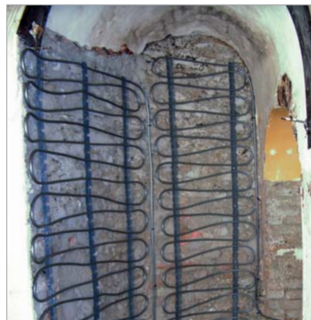
Historische Bausubstanz mit gewölbten Wänden mit Bruchstein und Ziegeln können mit der Nassputzvariante des Flächentemperiersystems Siccus nachhaltig mit einer modernen Flächenheizung versehen werden.
