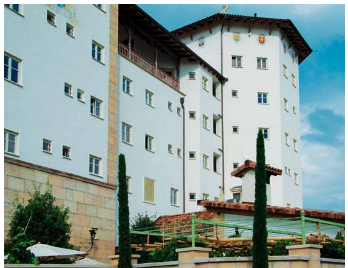
Damit der Rauch ins Freie entweichen kann, klappt an der Außenfassade automatisch ein etwa 1,4 x 1 m großes Bild mit einem christlichen Motiv zur Seite (hier im geschlossenen Zustand).
