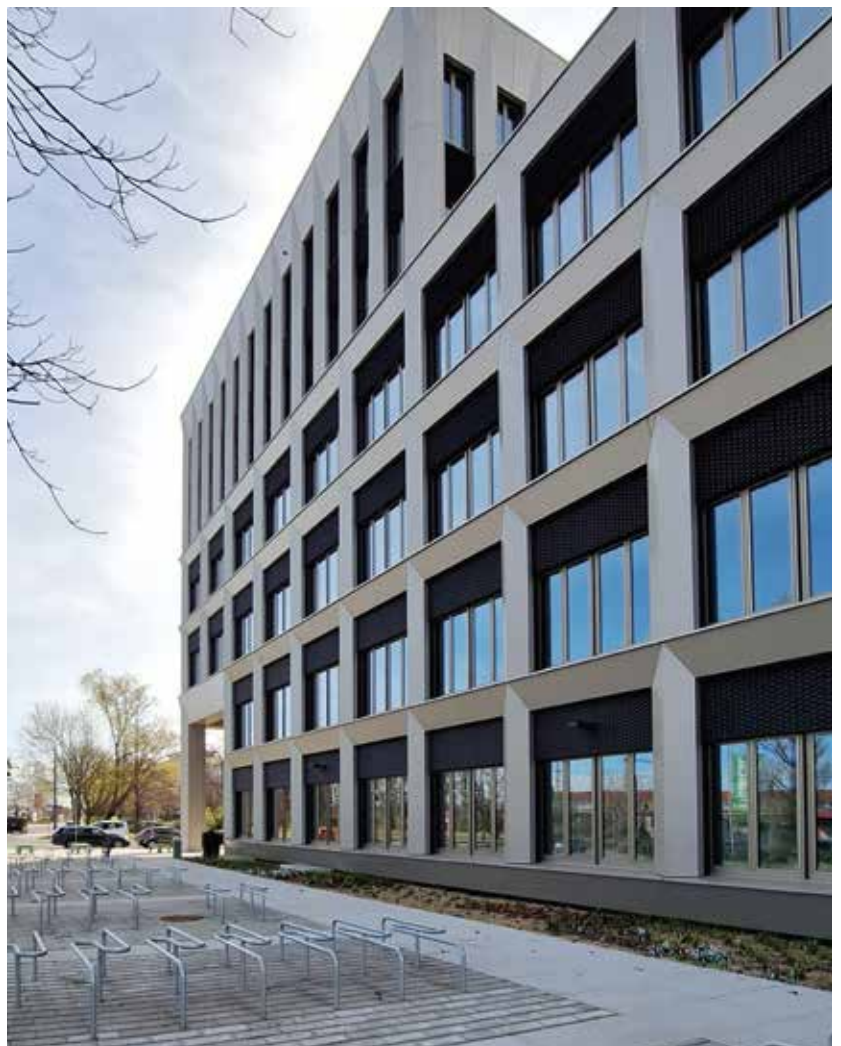
AUSSENANSICHT HTW Dresden
