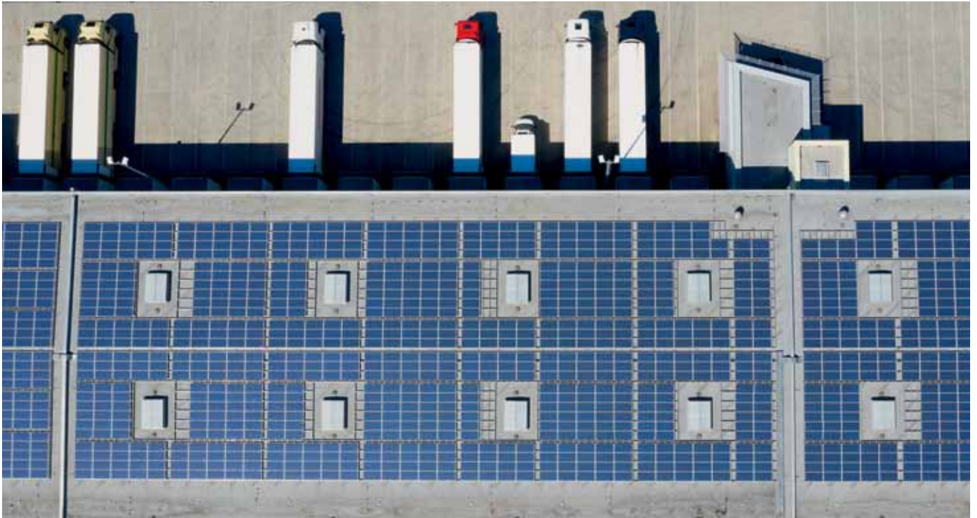
Bild 1 LOGISTIKHALLE mit Dach-PV-Anlage
