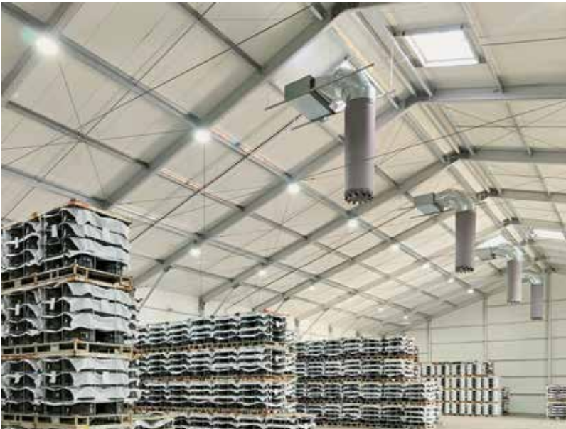
Hisense-Kanalgeräte mit speziellen Luftsäcken zur Sicherung einer gleichmäßigen Luftverteilung
