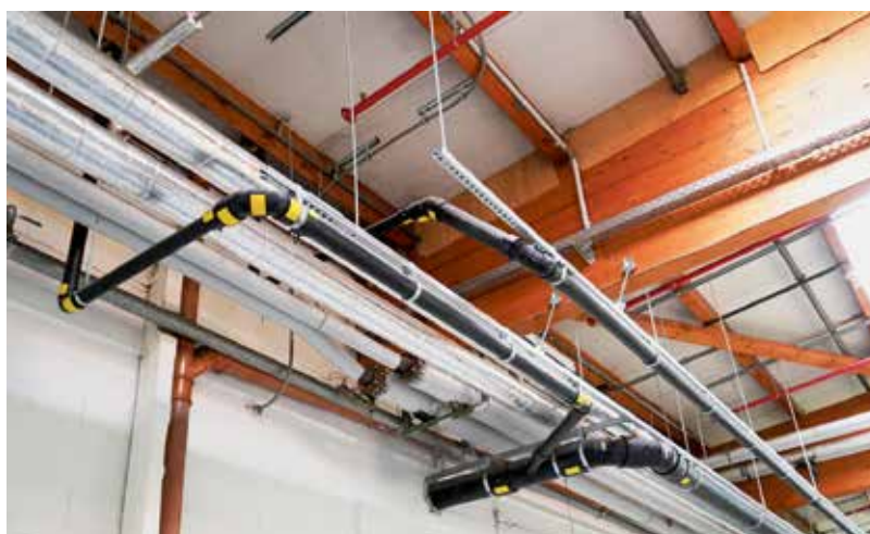
Drunter und drüber: E-Muffen sichern jede Richtungsänderung. Von oben führt die Hauptentwässerung in die Sammelleitung der Notentwässerung.
