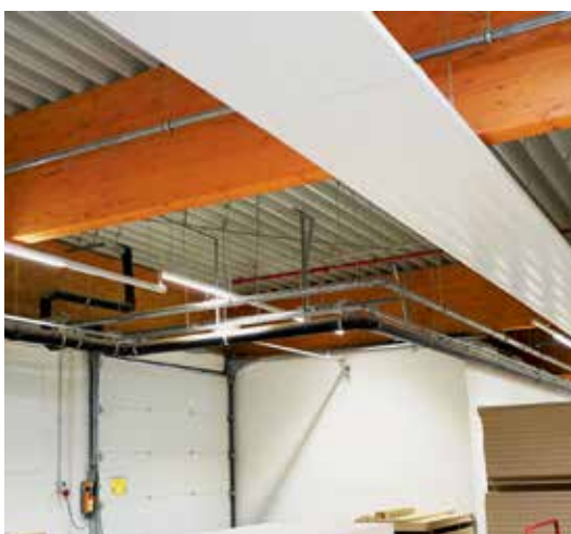
Das Sita Schienensystem übernimmt eine tragende Rolle und fixiert die Rohre des druckbeaufschlagten DSS-Rohrsystems.
