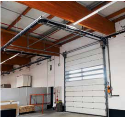
Platz für das Rolltor: Die wasserführenden Leitungen mussten so verlegt werden, dass sie dem Rolltor beim Hochfahren nicht im Wege sind.
