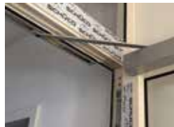
Brandschutztüren gewährleisten Sicherheit für die Bewohner.
