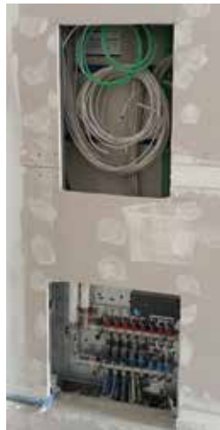
Im Fertigteilerschacht werden die Versorgungsleitungen installiert.
