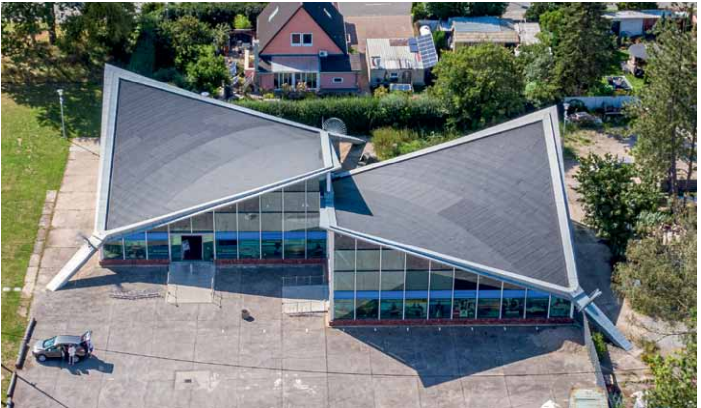
Von oben ist die ikonische Form der Dachlandschaft gut zu sehen. Die Erdwärmekollektoren und der Ground-Cube befinden sich unter der Rasenfläche links auf dem Bild.
