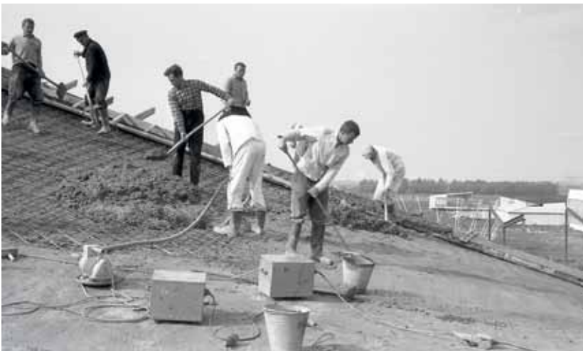
In nur 160 Tagen errichtete Ulrich Müther den Pavillon mit seiner nur 7 cm dicken Stahlbetondecke. Die Berechnung von Form und Statik umfasst 17 Variablen und wurde mit einer der damals gebräuchlichen Rechenmaschinen vorgenommen.
