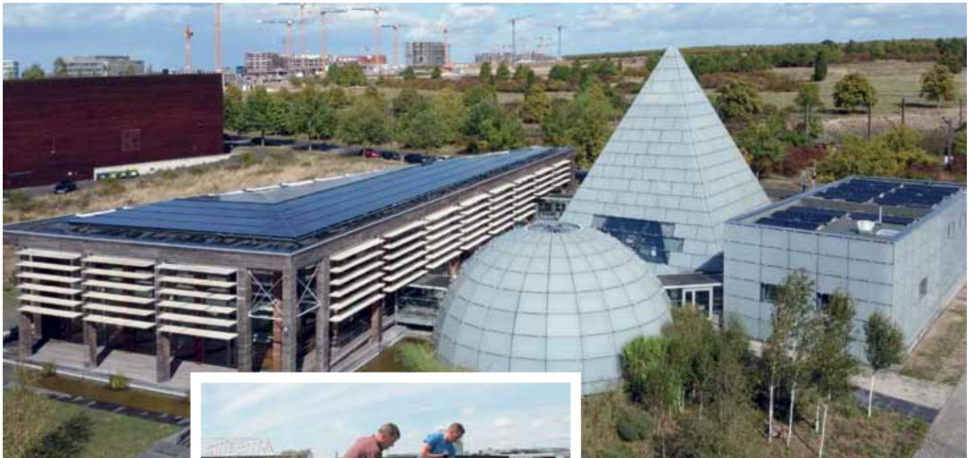
Oben: Dänischer EXPO-Pavillon in Hannover mit gebäudeintegrierter PVT-Anlage auf dem Hauptgebäude
