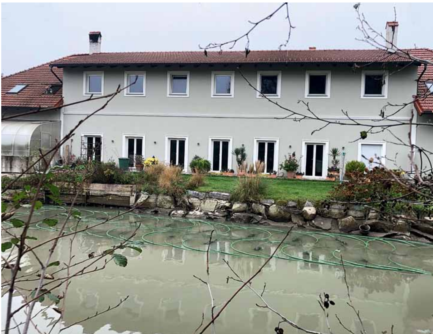
Fischteich als Wärmequelle für den Vierkant Bauernhof
