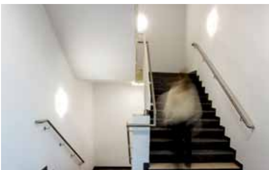
Leuchten der R-Serie von Steinell im Treppenhaus
