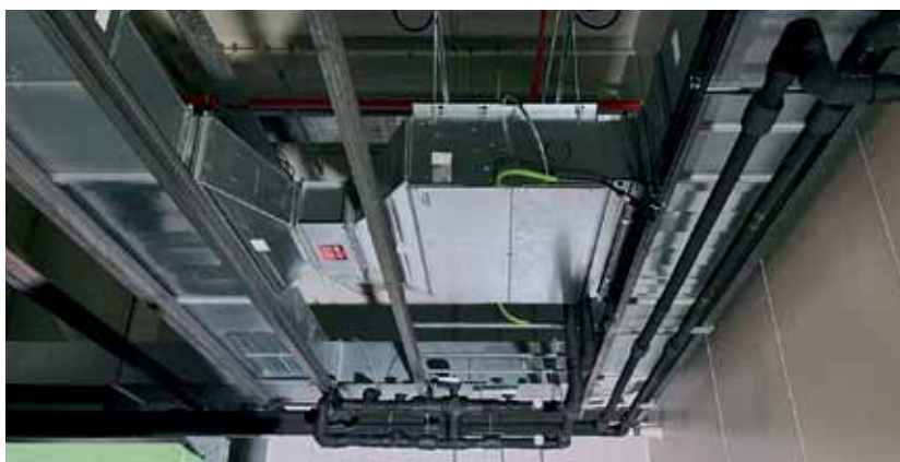
Kanalgerät der Galletti UTN-Serie zur Umluftkühlung
