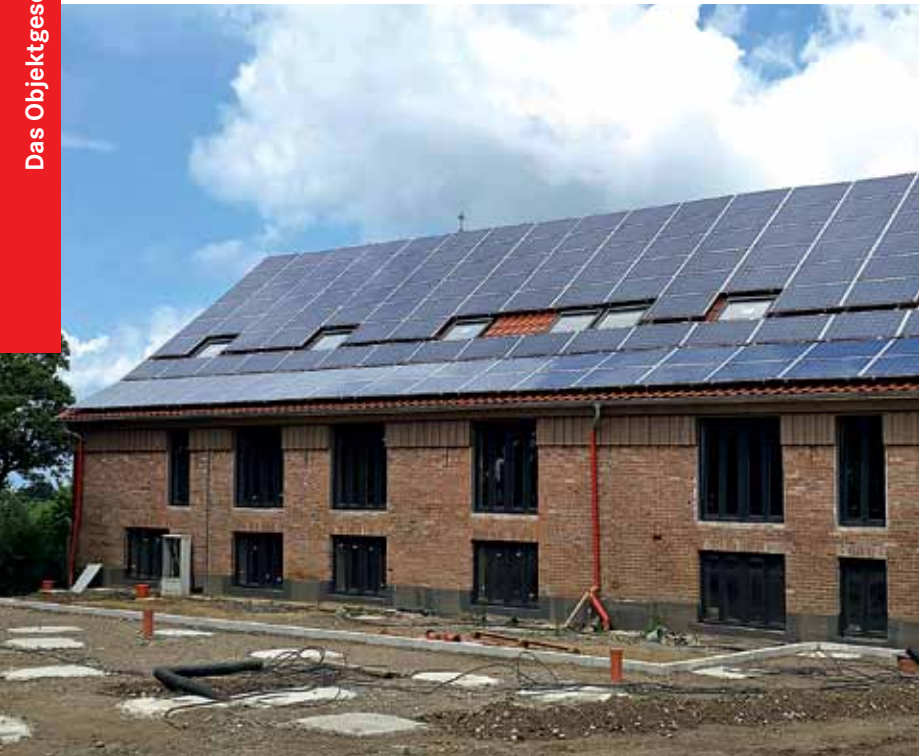
Sanierung eines denkmalgeschützten Altbaus (Bild mit alter PV-Anlage) in Wolfsburg-Ehmen
