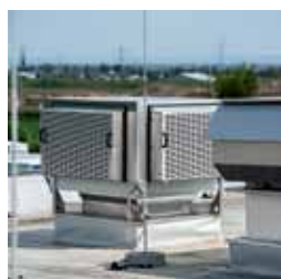
Das adiabate Kühlsystem Colt CoolStream sorgt insbesondere im Sommer für bessere Arbeitsbedingungen.
