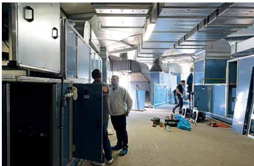
① Im Technikbereich der Eisschnelllaufhalle arbeiten drei baugleiche Lüftungs- und Entfeuchtungsanlagen der Munters GmbH.
