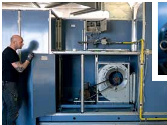
① Im Technikbereich der Eisschnelllaufhalle arbeiten drei baugleiche Lüftungs- und Entfeuchtungsanlagen der Munters GmbH.
