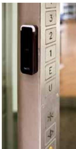
Salto Wandler zur Aufzugssteuerung schalten nur die Etagen frei, für die die Passagiere berechtigt sind.
