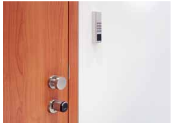
Innentüren, z.B. zu Werkeräumen sowie einzelnen Büros und Besprechungszimmern, sichert die Volksbank Backnang mit elektronischen Salto Neo Zylindern.
