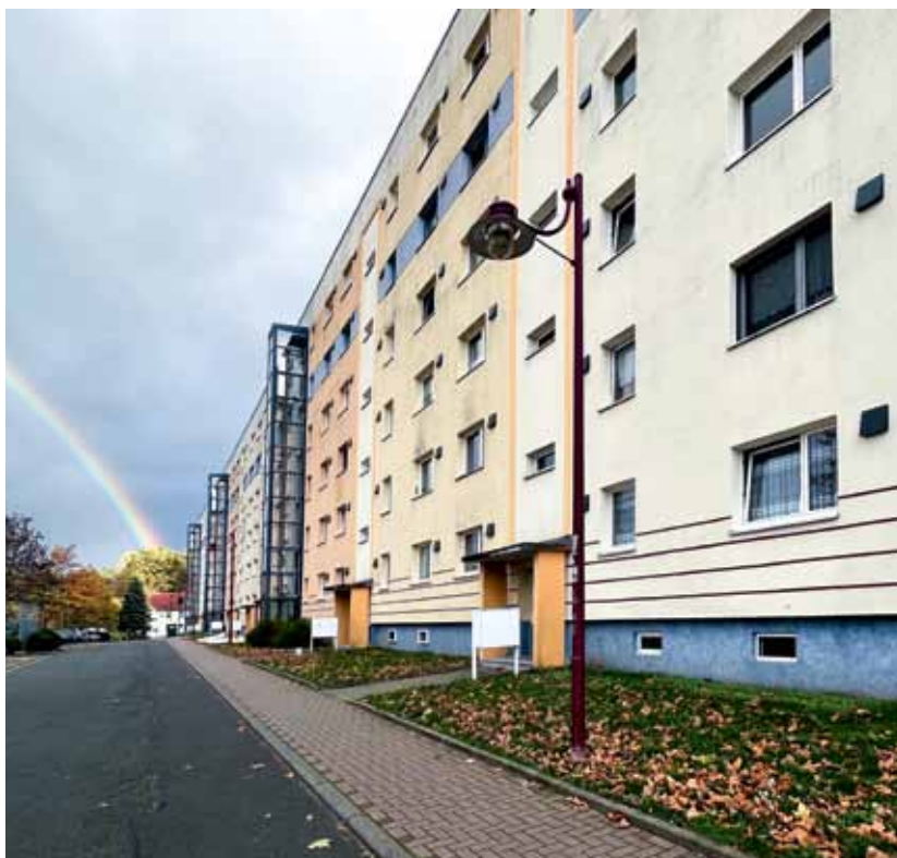
Außenansicht Wohnblock WBS 70
