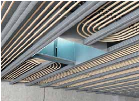
Moduldecke Roth Werke GmbH, 27 mm Aufbauhöhe durch Integration ins Schienensystem
