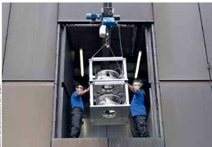
4 – Über den Außenaufzug konnten die RadiPac einfach in die Lüftungsanlage Süd eingebracht werden.
