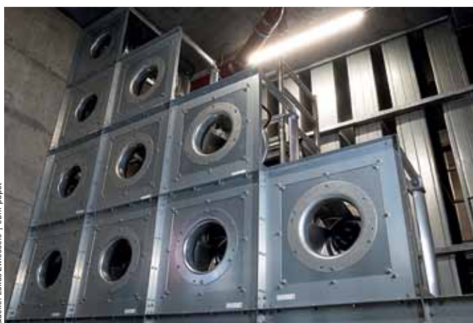
5 – Das neue FanGrid besteht aus 24 RadiPac und ersetzt den alten Einzelventilator.
