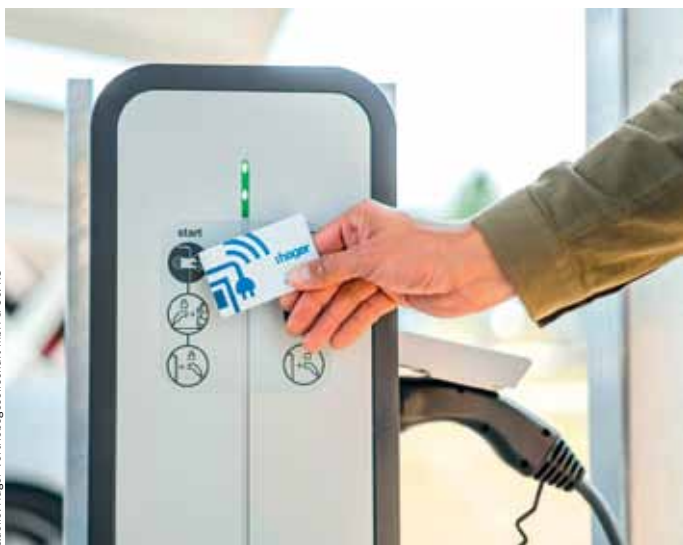
Die RFID-Karten schalten die Ladestationen frei und dienen gleichzeitig als Zutrittskarten zum Firmengebäude.
