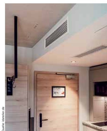
Nahezu unsichtbare Installation von Kanalanschlussgeräten
