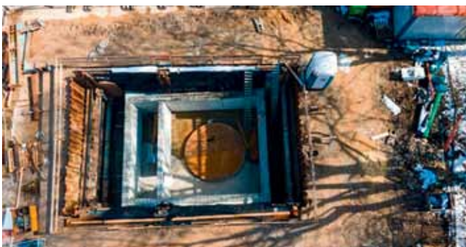
2 – Bau der Brunnen für das Projekt „Neue Balan“ in München
