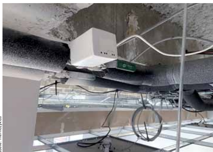
Stellantrieb SK an einer Heizplatte in einer Zwischendecke
