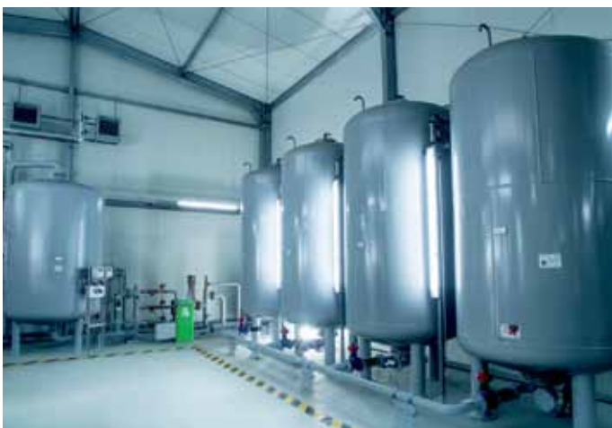
Druckhaltungsstationen und Entgasungsanlage von Reflex
