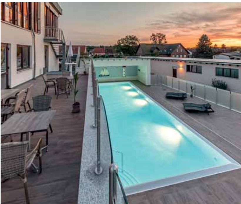
Der Außenpool dient als Speicher für überschüssige Wärme der BHKWs.
