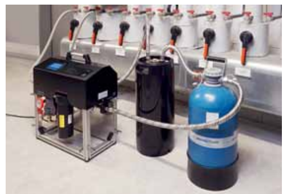
⑦ Mit der Sauerstoffzehrpatrone OxRed von perma-trade kann nach Art einer „Filterpatrone“ der im Anlagenwasser gelöste Sauerstoff direkt beim Hindurchströmen eliminiert und auf diese Weise Korrosionsproblemen entgegengewirkt werden.
