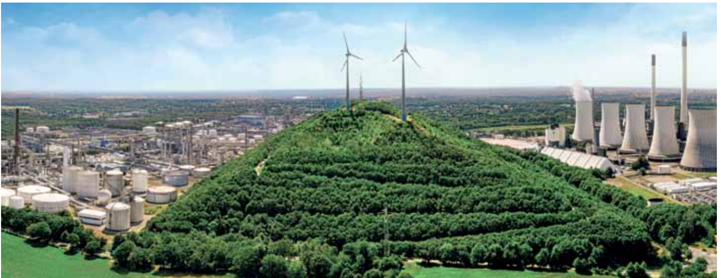
Eines der größten Abwärmeprojekte in NRW soll zukünftig rund 30.000 Haushalte im nördlichen Ruhrgebiet mit Fernwärme versorgen.
