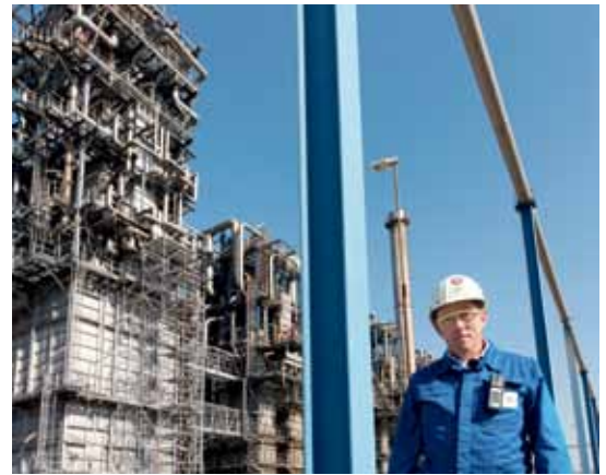
Bis die industrielle Abwärme aus der BP-Raffinerie Scholven ausgekoppelt und in das Fernwärmenetz von Uniper eingespeist werden kann, muss eine entsprechende Infrastruktur geschaffen werden.
